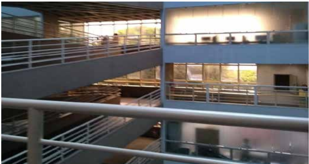
IES 4 - Edificio principal de 7 pisos y rampas
