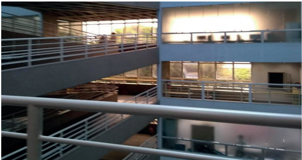
IES 4 - Edificio principal de 7 pisos y rampas
